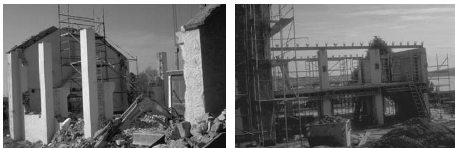
Aus der Umbauphase der Gnadenkirche
