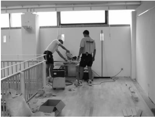
Der vom Förderverein gesponserte Parkettboden wird von den Handwerkern verlegt
